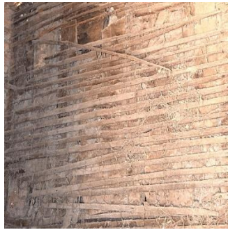
Figure 48. Simple wattle and daub - Fermentãos.
