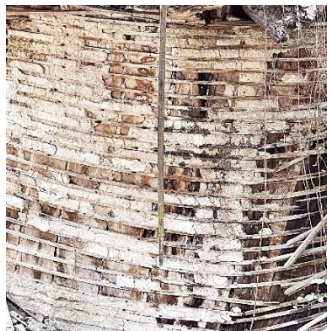
Figure 49. Simple wattle and daub - Alqueidão.
