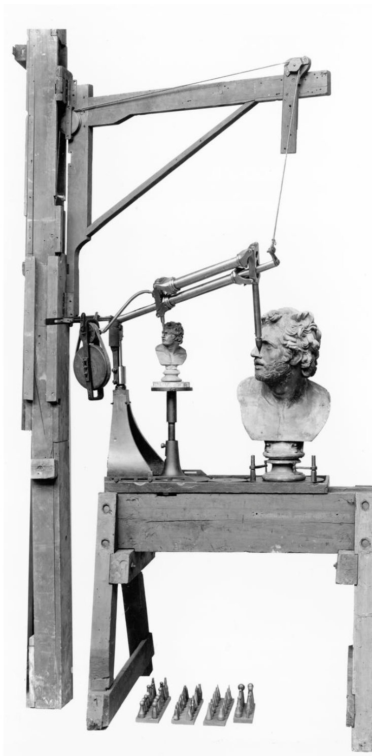
Фото. 20. 3D-пантограф, разработанный и построенный Б. Чевертоном, 1826 г. Механизм предназначался для автоматического изготовления уменьшенных копий скульптур (Музей Науки, Лондон, sciencemuseumgroup.org.uk ).
