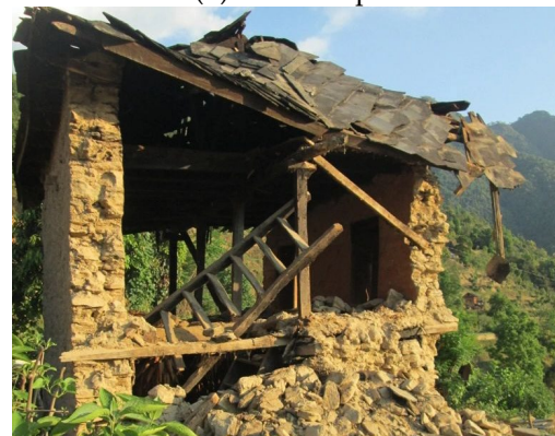
5 (d) Out-of-plane loss of the side wall
