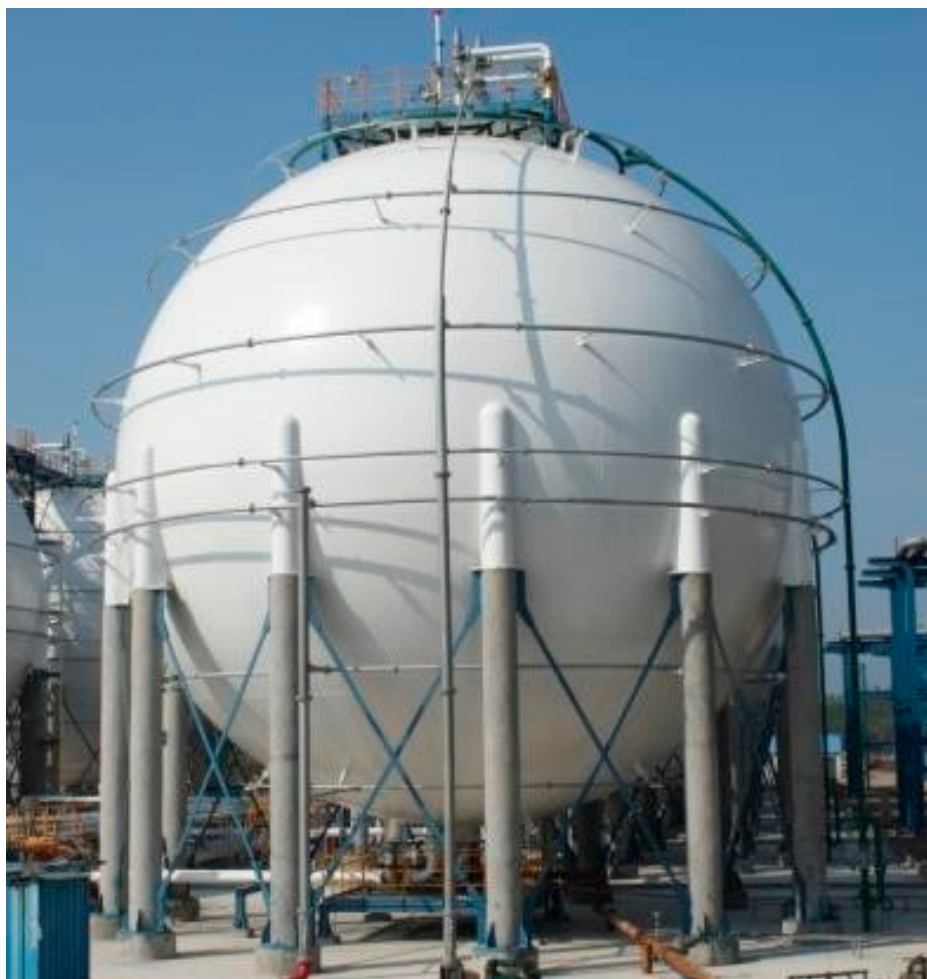
Figure 1. Spherical LNG storage tank.
