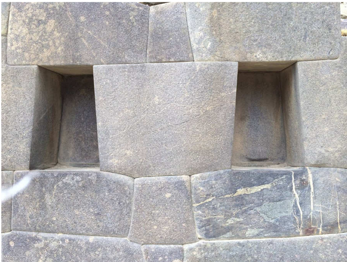
Фото. 11. Храм десяти ниш, Ольянтайтамбо (А. Fuchs, 2008, sy-akka.de/wordpress). Обратите внимание на симметричное расположение блоков в кладке.
